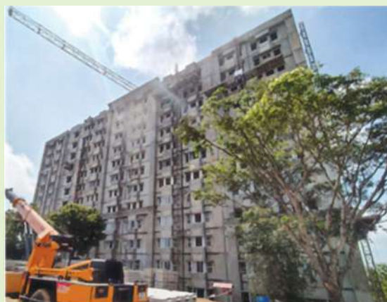
Actual Site photos
